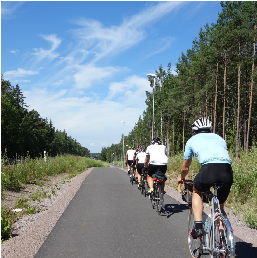
Bra cykelväg Furuvik-Gävle
