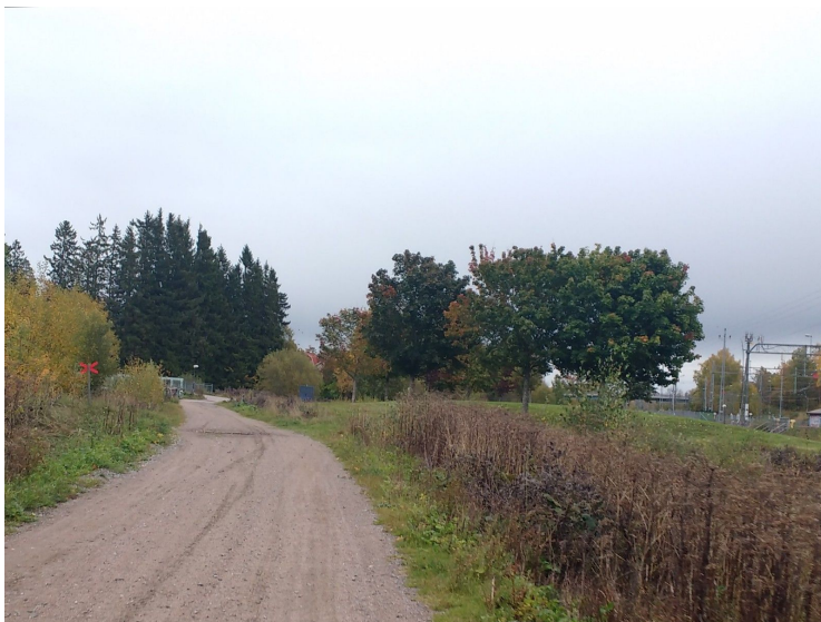
Del av cykelvägen Tobo-Örbyhus som saknar beläggning
